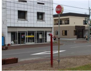
防火水槽 58基 (内: 簡易水槽10tが2基)
